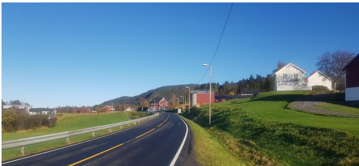
Figur 5. Viser det karakteristiske landskapsbildet. Bølgende terreng med flekkvise partier dyrket mark og spredt bebyggelse, samt skogkledde åser.
