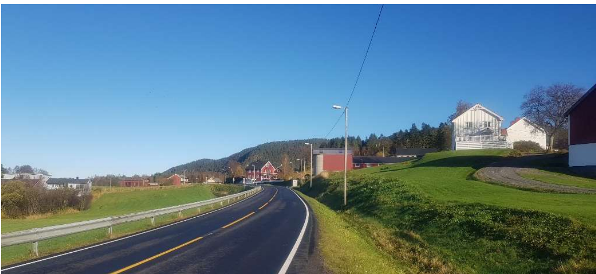
Figur 5: Viser det karakteristiske landskapsbildet. Bølgende terreng med flekkvise partier dyrket mark og spredt bebyggelse, samt skogkledde åser.
