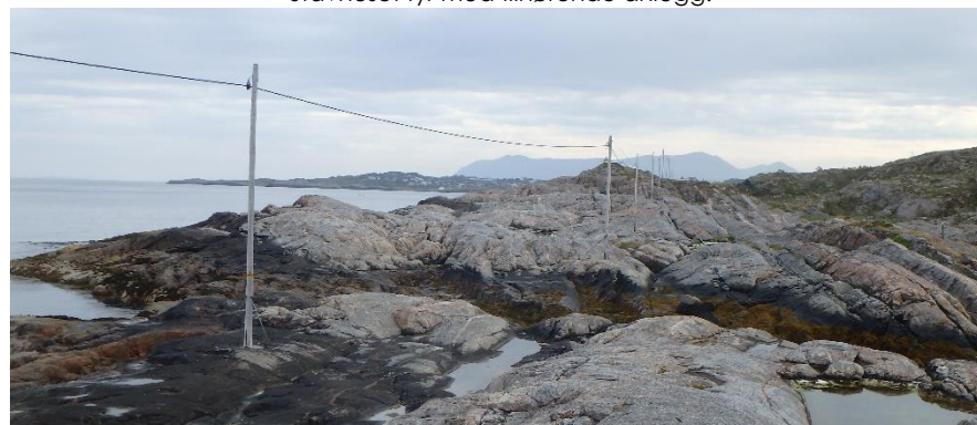
Strømforsyning til fyret er en stolperekke på svaberget.
