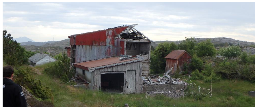
Driftsbygning på Tøfta
