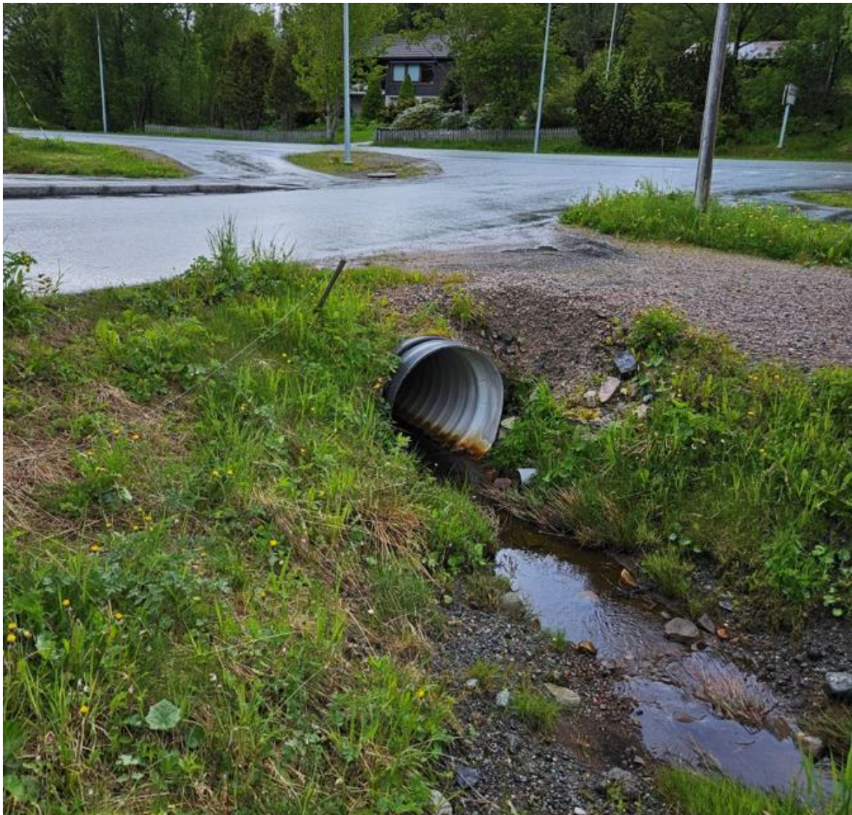
Figur 5: Foto av rør under Miljøveien (punktnummer 1), som forventes å være avgjørende for vannlinja ved deler av kartleggingsområdet.
