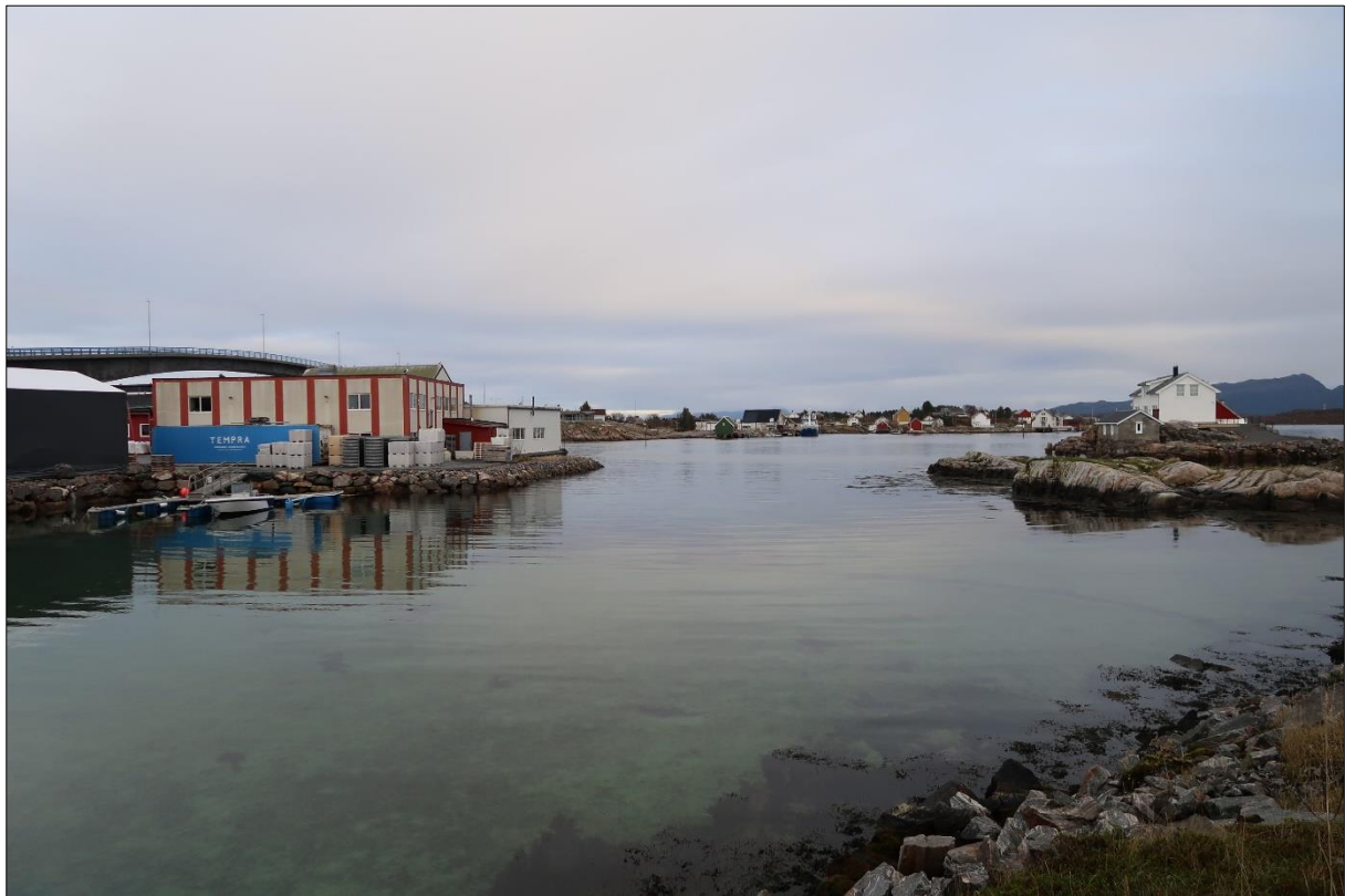
Bildet viser eksisterende virksomhet og deler av den omkringliggende bebyggelsen. Bygget til høyre i bildet er registrert som enebolig. Foto: Ikon AS
