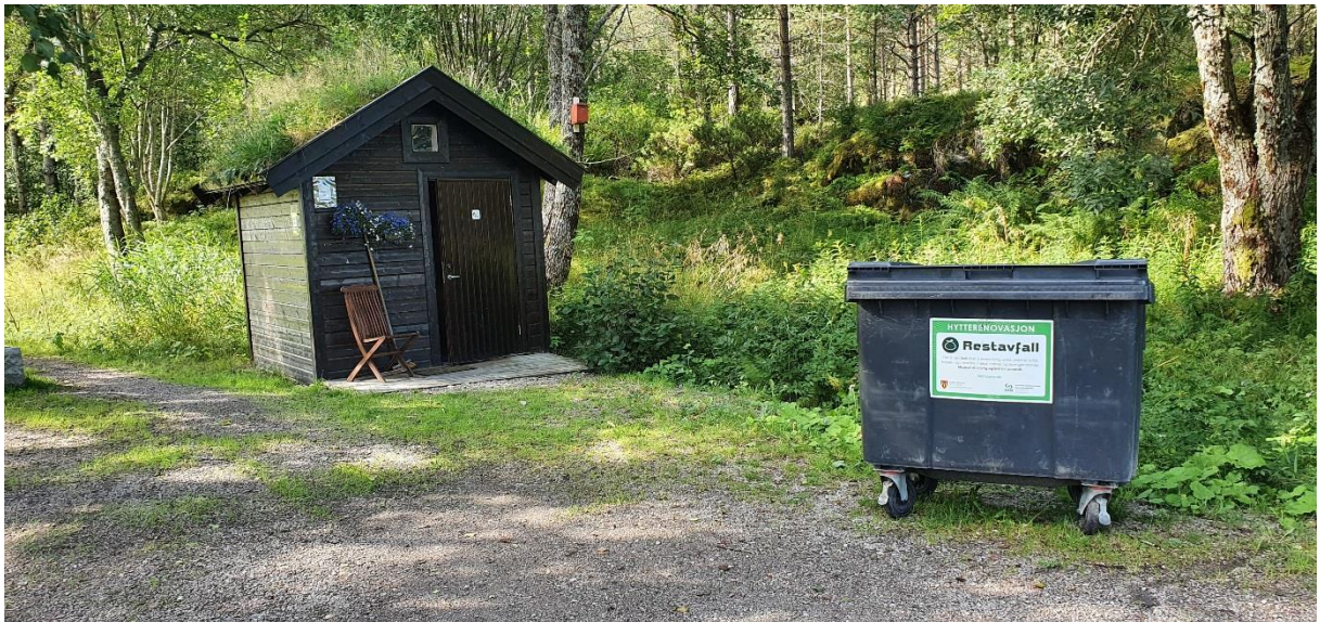
Toalettbygg og renovasjonsdunk
