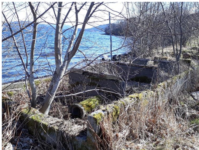
Rester etter bygdesaga ved prestegårdsnaustet på Kvernes (foto: mtb)
