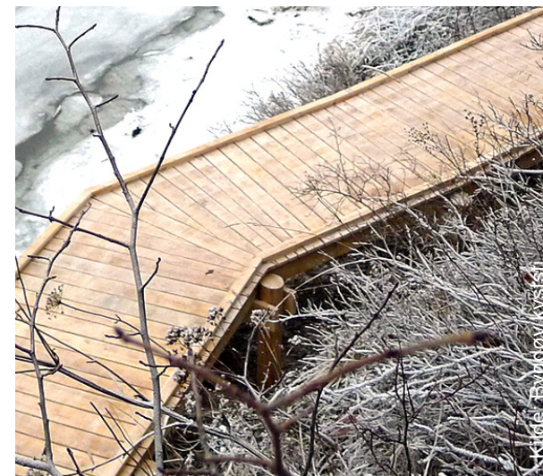
Kant i samme materiale som sti. Trekant ligger med avstandsholder for luft og avrenning.
