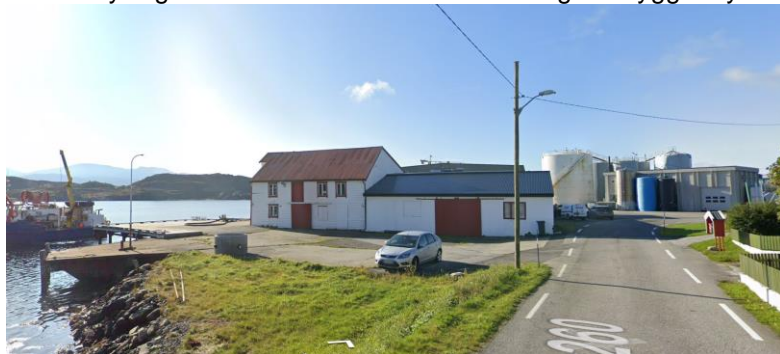
Figur 7: Planområdet sett fra øst mot sør-vest. Kilde: Kilde google.maps.no: 10.02.2021.
