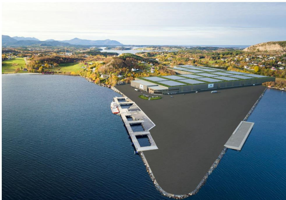
Figur 10: Skisse av mulig utforming av anlegg og utfylling i sjø. (AIP/NORCAD)
