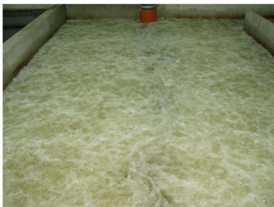
FIGUR 16 - UTLUFTINGSSYSTEM FOR DYKKEDE BIOLOGISKE FILTRE.
