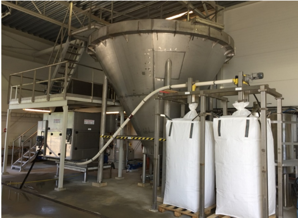
FIGUR 30 - SLAMBEHANDLINGSANLEGG MED TØRKEPROSESS BILDE: YNGVE PAULSEN
